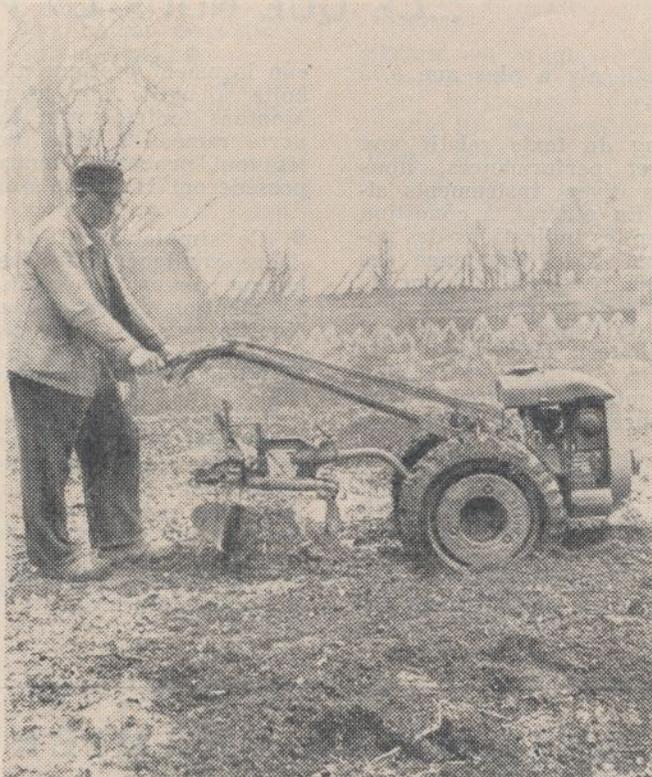
Nous avons également passé à notre banc d'essais pratiques, le Staub 4 CV. Celui-ci s'est révélé fort maniable et nous l'avons principalement employé dans des petits jardins encombrés d'arbres et limités par des clôtures fixes. Toutefois, les capacités de traction de ce motoculteur sont apparues plutôt modestes, si bien que nous considérons le PP-2B comme limité à des travaux de jardinage ou entretien de propriété. A condition toutefois que les terres à retourner soient légères et saines.
